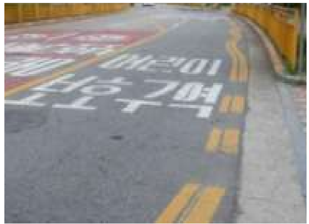
송수-3 종점부 전경
