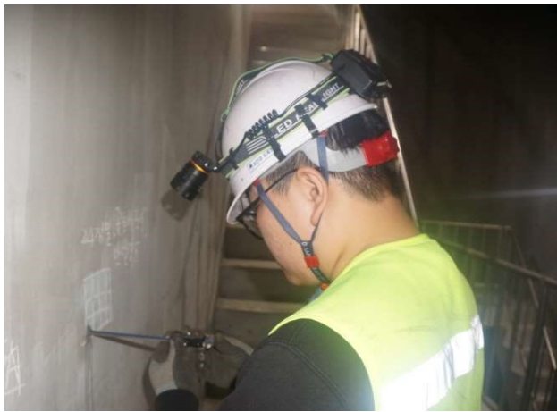
탄산화 깊이 측정
