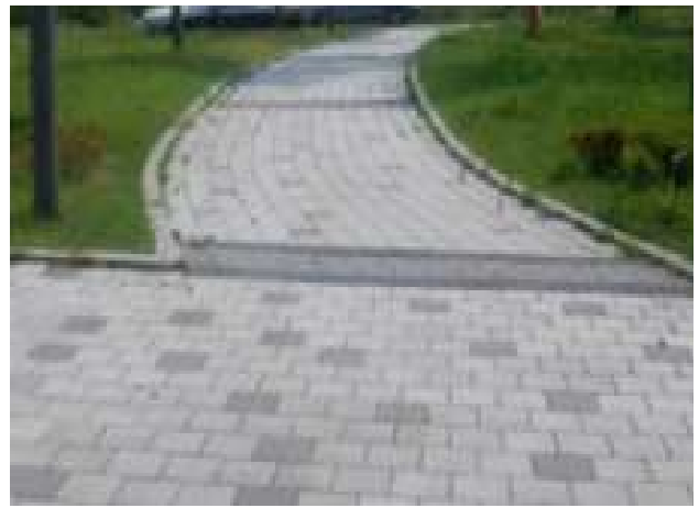
송수-6 종점부 전경
