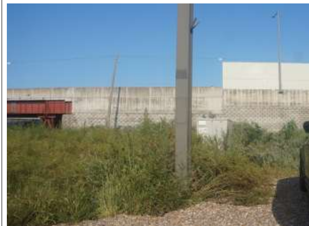
송수-4, 5 종점부 전경
