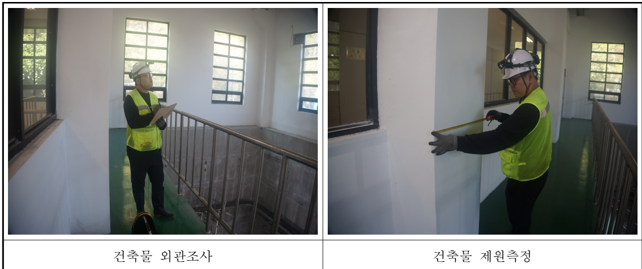
【사진 4.1】 시설물 외관조사
