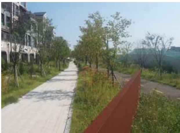
송수-4, 5 시점부 전경
