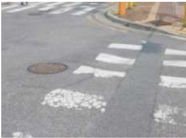
송수-3 시점부 전경
