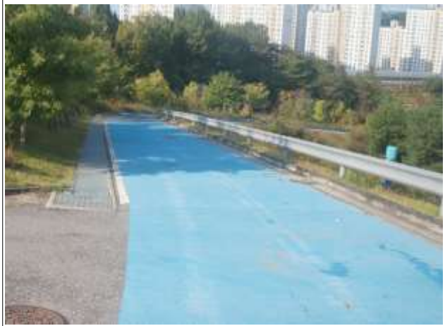
송수-1, 2 종점부 전경
