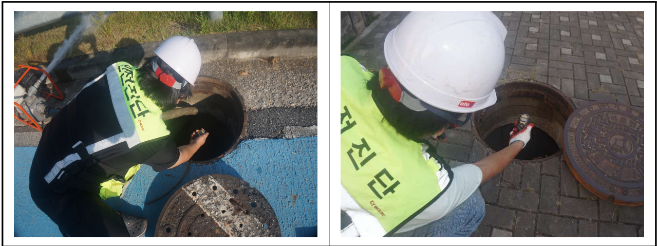
[밸브실 산소 및 유해가스 농도 측정]
